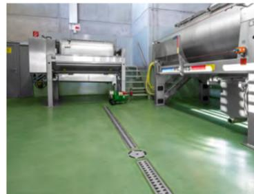
Kombirinne randverstärkt mit Mittelstegrost und Bodenablauf Eurosink ESJS100-2A
