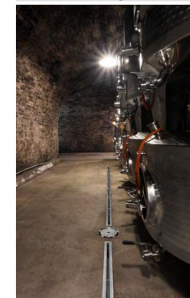
Schlitzrinne randverstärkt (Klasse M, staplerbefahrbar) mit Bodenablauf Eurosink ESW150-2A mit Rinnenanschluss
