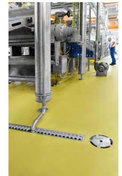
Kombirinne randverstärkt (Klasse M, staplerbefahrbar) mit Mittelstegrost und Bodenablauf Eurosink ESJS100-1A mit Rinnenanschluss
