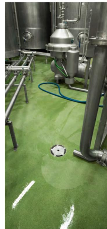
Bodenablauf Eurosink ESJS100, Ablaufleistung ca. 2,6 l/sek., Belastungsklasse M (125 kN)
