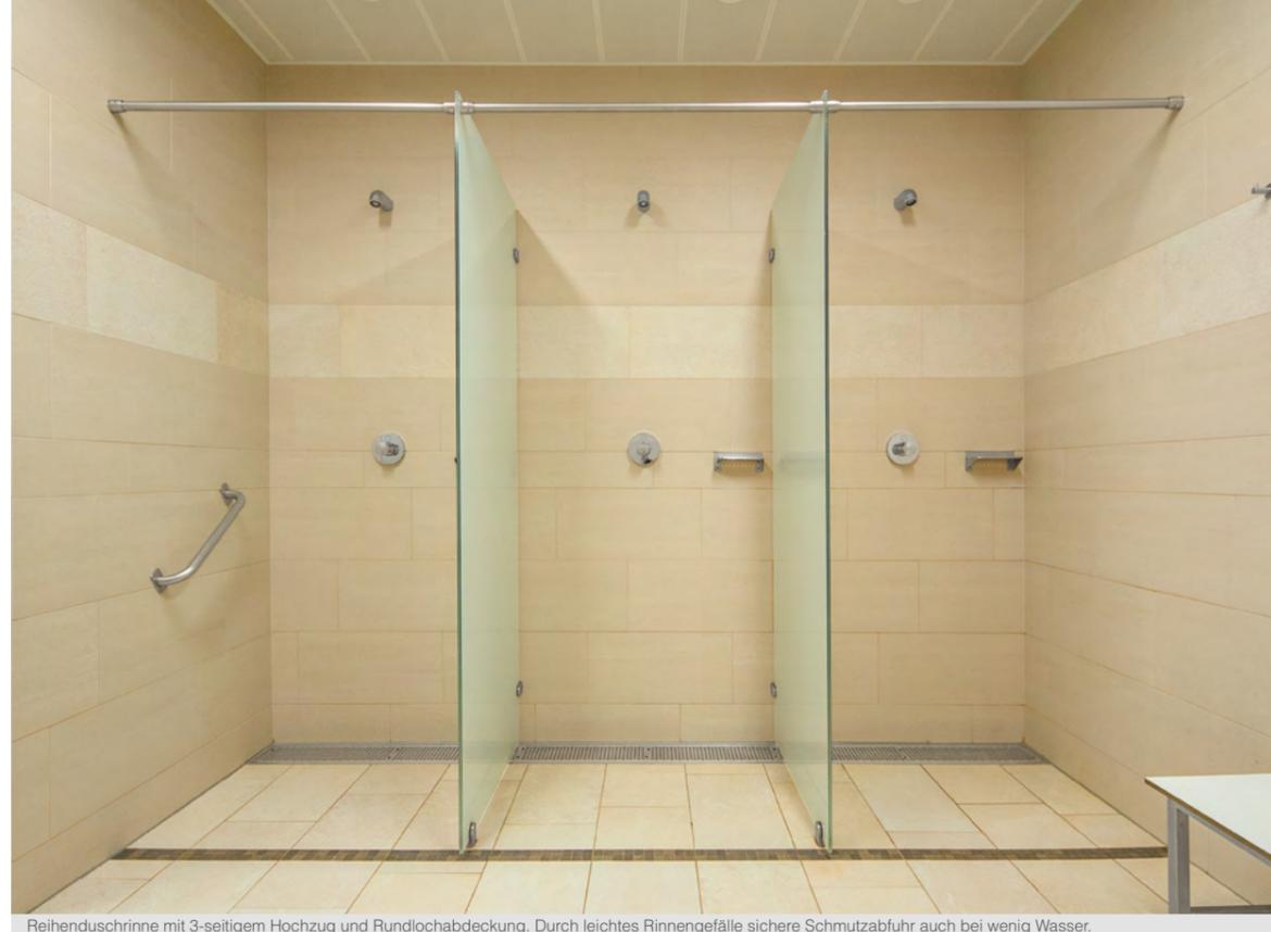
Reihenduschrinne mit 3-seitigem Hochzug und Rundlochabdeckung. Durch leichtes Rinnengefälle sichere Schmutzabfuhr auch bei wenig Wasser.
