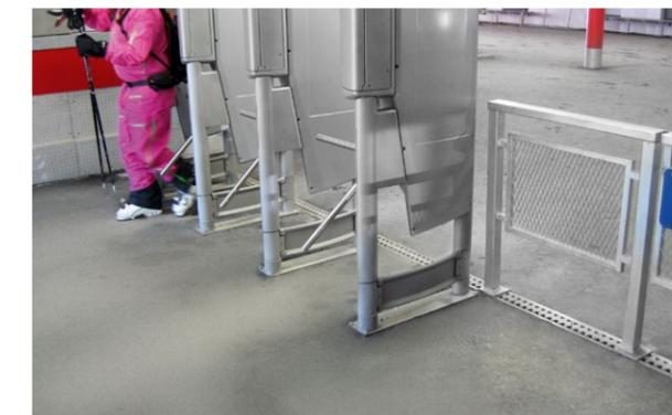
Talstation - Entwässerung durch randverstärkte Kombirinne
