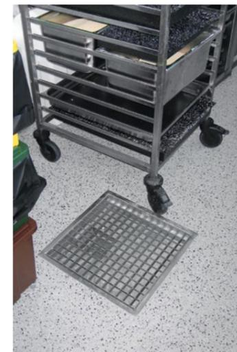
Kastenwanne mit Gitterrostabdeckung
