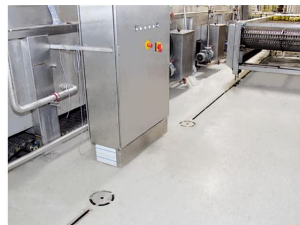
Schlitzrinnen mit Bodenabläufe „Eurosink“ sorgen für optimale Entwässerung
