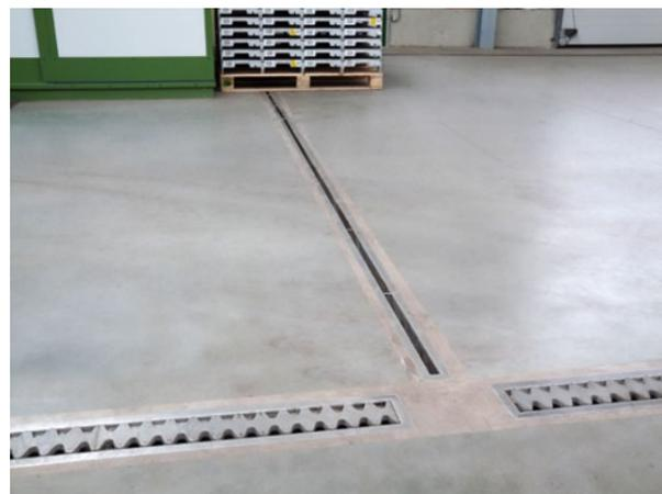
Schlitzrinne + 2 Kombirinnen mit Mittelstegabdeckung, randverstärkt für den Staplerbetrieb
