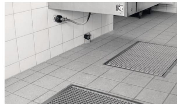
Bodenwanne mit Gitterrostabdeckung
