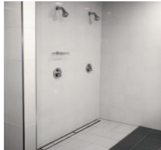
Duschraum der FMT, Spezialanfertigung von Einzelduschrinnen mit verfließbarer Abdeckung
