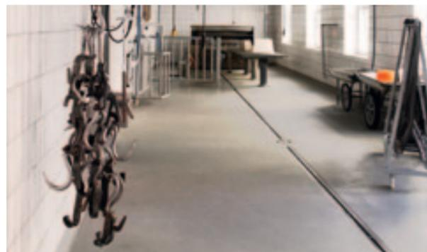
mit einer neuen Hochdruckreinigungsanlage ausgestattet wurde. In grenzüberschreitender Zusammenarbeit, wenn man so will: Nirotec lieferte stabile und den höchsten Anforderungen entsprechende Eurosink-Abläufe mit Geruchsverschlüssen sowie Schlitzrinnen in antibakterieller Hygieneform für einfache Reinigung.
