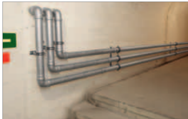
Abführung der Öldämpfe durch das robuste Rohrsystem Niropipe
