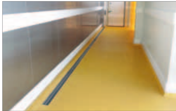
Kombirinne; Abdeckung: Mittelstegrost
