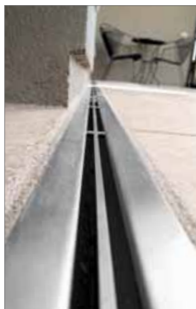
Doppelschlitzzrinne mit Sichtsteg
