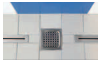
Sanitärablauf zur Entwässerung der beiden Badrinnen
