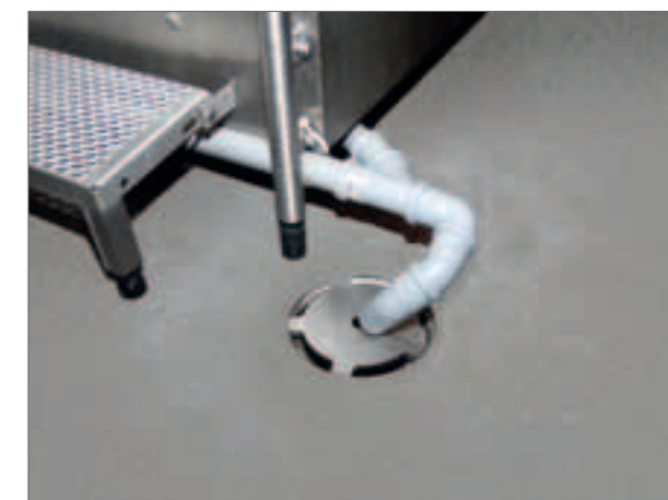
Eurosink Industrieablauf mit 5-Sternabdeckung
