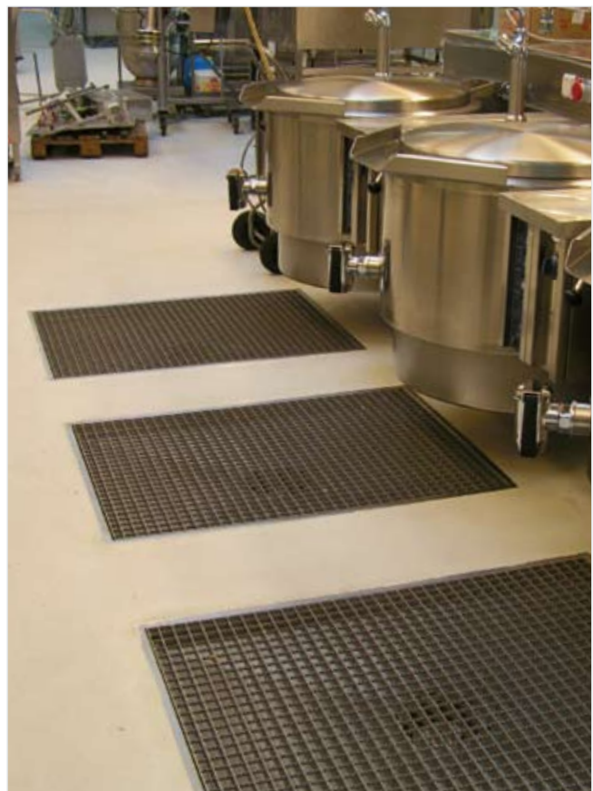
NIROTEC Bodenwannen in der neu gebauten Krankenhausküche
