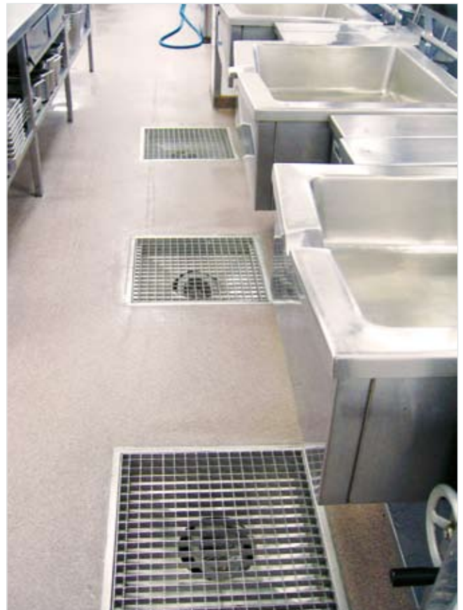
Siemens Elin setzt beim Neubau der Kantine auf kompromisslose Qualität und verbaut die stabilen Nirotec Bodenwannen
