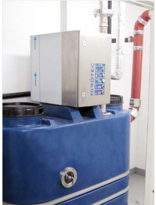
NIROTEC Fettabscheider für die Gastronomie reinigt zuverlässig das Abwasser
