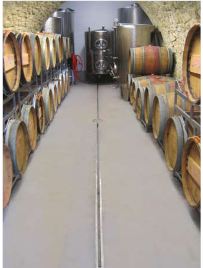
NIROTEC Entwässerungs-System: Randverstärkte Schlitzrinnen und der „Eurosink Junior“- Gully
